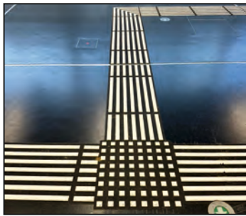
Altes gefrästes Leitsystem im Vordergrund. Neues Leitsystem im Hintergrund.
